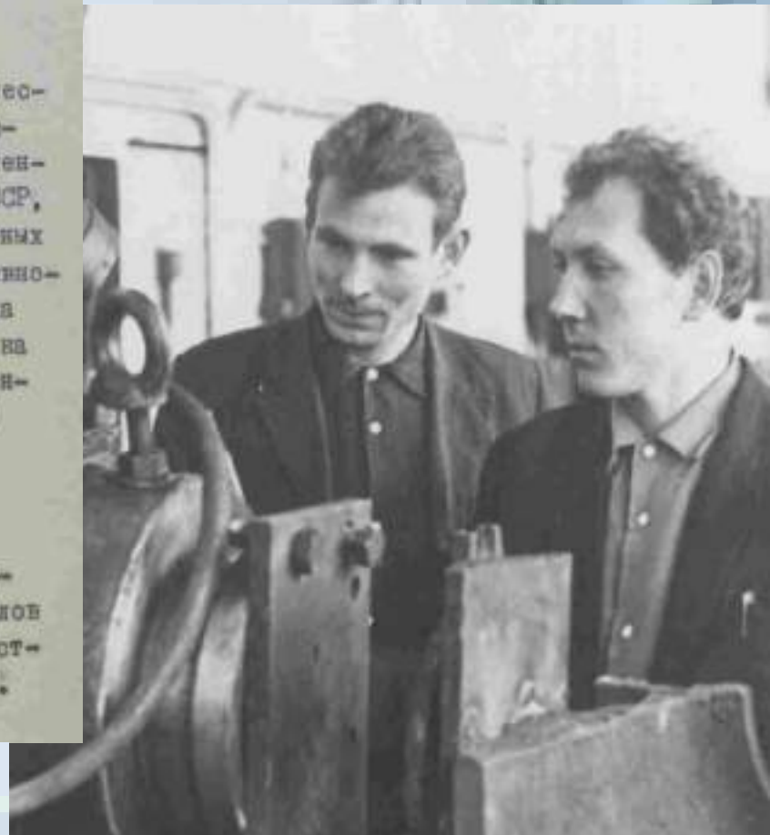
Электромонтёр Анатолий Грабский и старший инженер Геннадий Епишкин испытывают раму тележки электровоза ВЛ-80 (1969) ЦДНИРО. Ф.Р-3619. Оп.6. Д.321. Л.1
